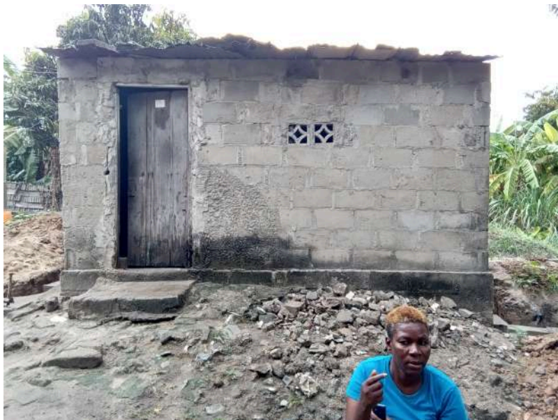
Habitação - Foto da esquina 2
