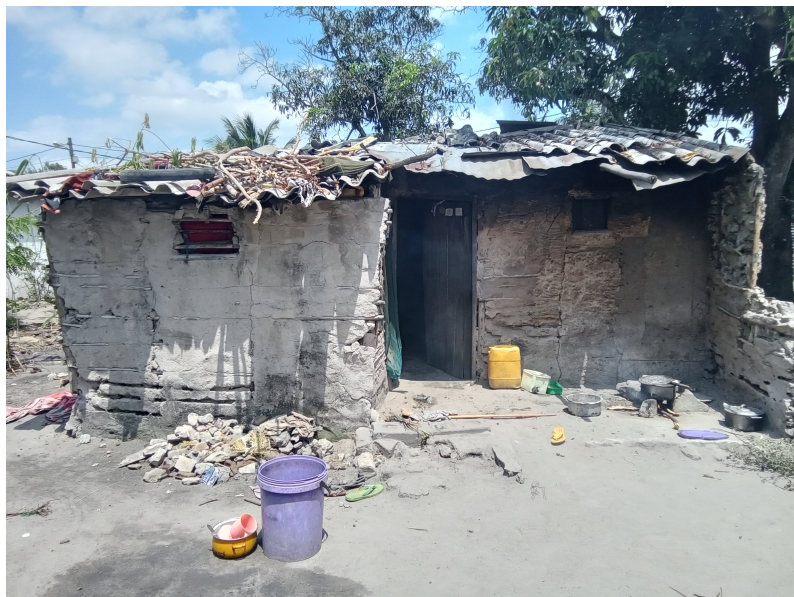
Habitação - Foto da esquina 2
