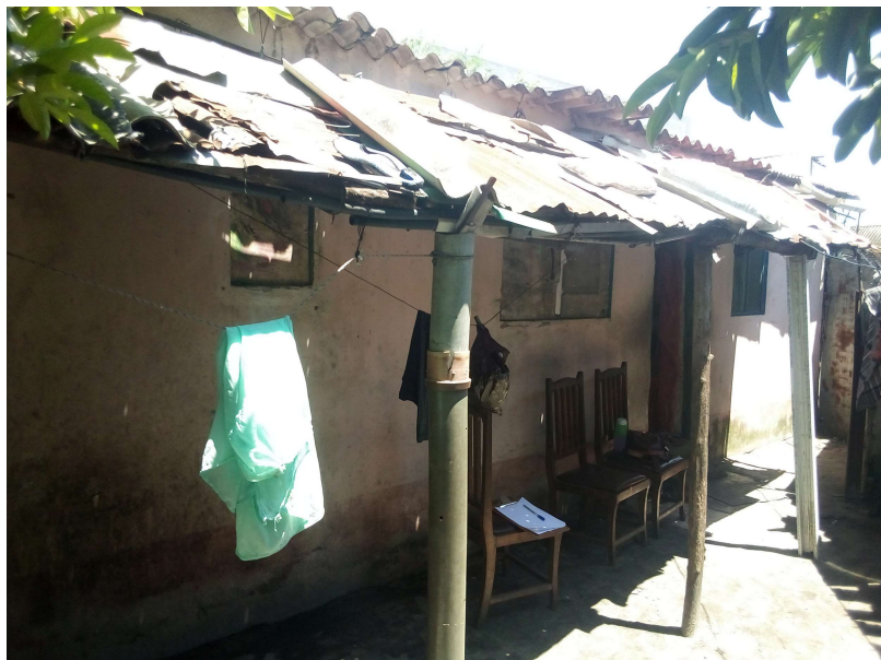
Habitação - Foto da esquina 2
