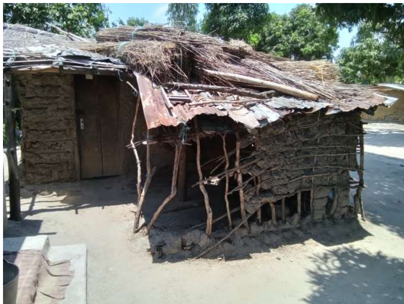
Habitação - Foto da esquina 2
