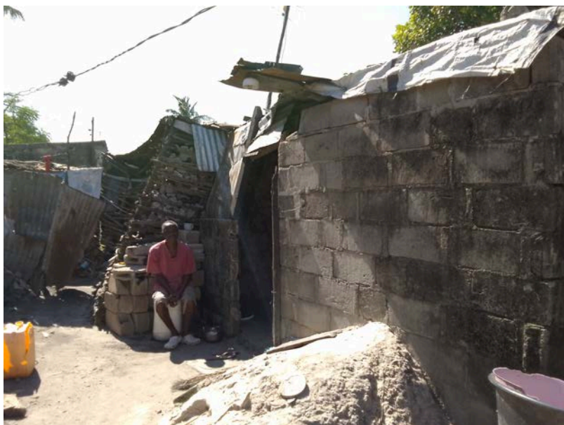
Habitação - Foto da esquina 2
