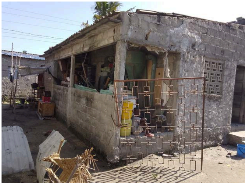
Habitação - Foto da esquina 2
