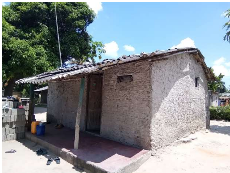
Habitação - Foto da esquina 2
