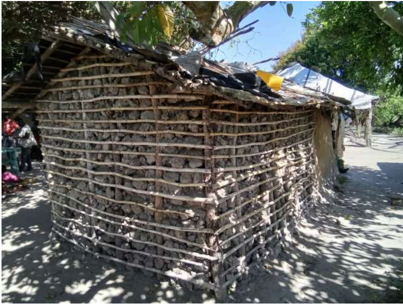
Habitação - Foto da esquina 4
