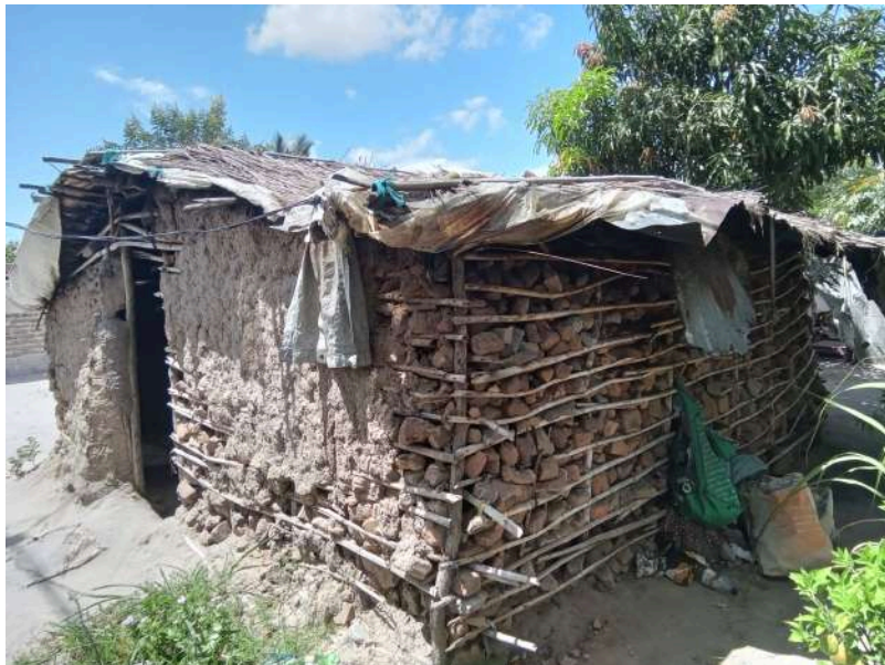
Habitação - Foto da esquina 2
