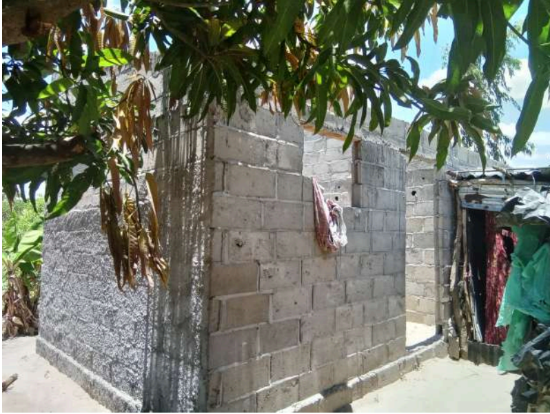
Habitação - Foto da esquina 2
