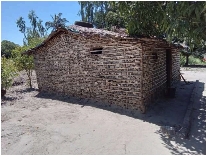
Habitação - Foto da esquina 2
