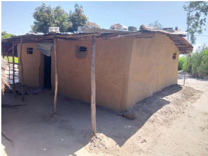
Habitação - Foto da esquina 2
