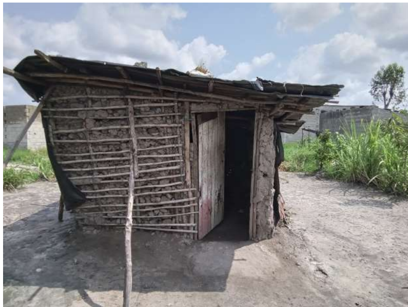
Habitação - Foto da esquina 2
