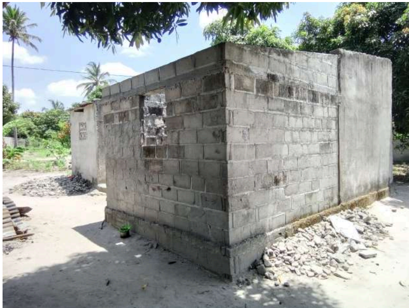
Habitação - Foto da esquina 2
