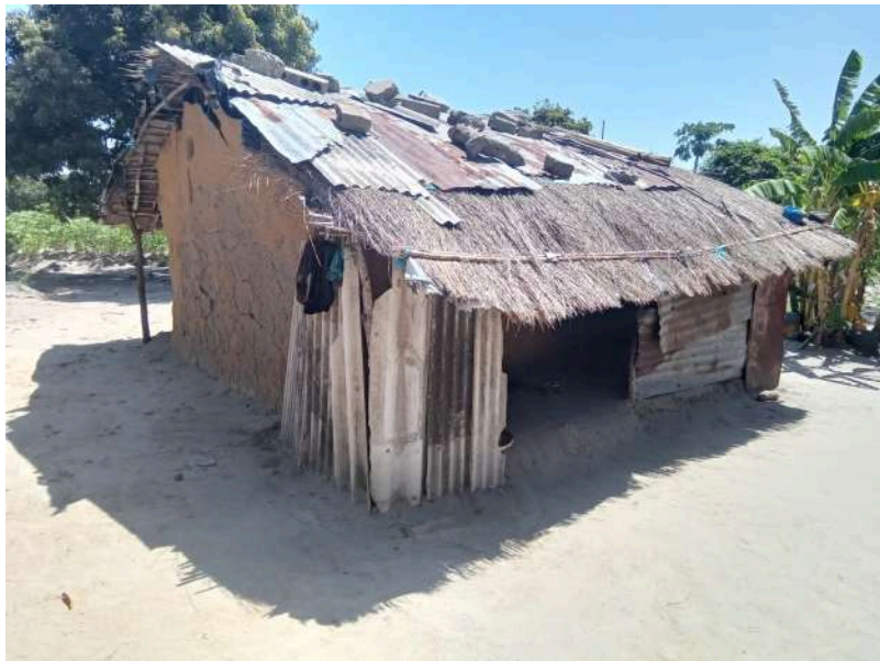
Habitação - Foto da esquina 2
