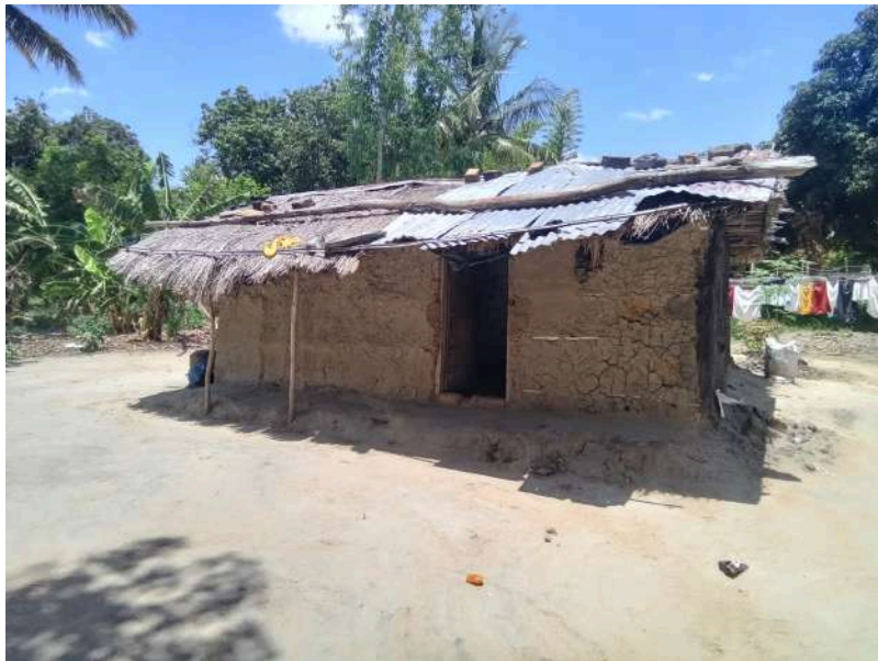
Habitação - Foto da esquina 2
