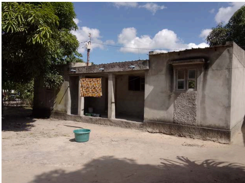
Habitação - Foto da esquina 2
