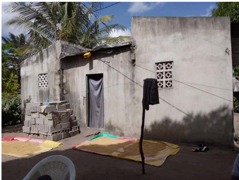
Habitação - Foto da esquina 2
