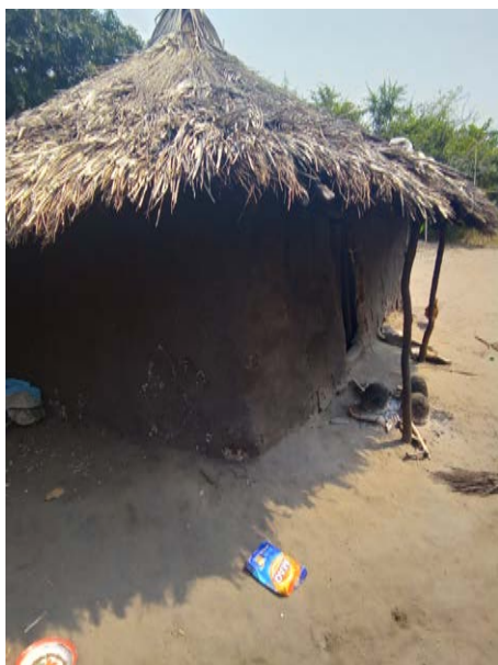
Habitação - Foto da esquina 2
