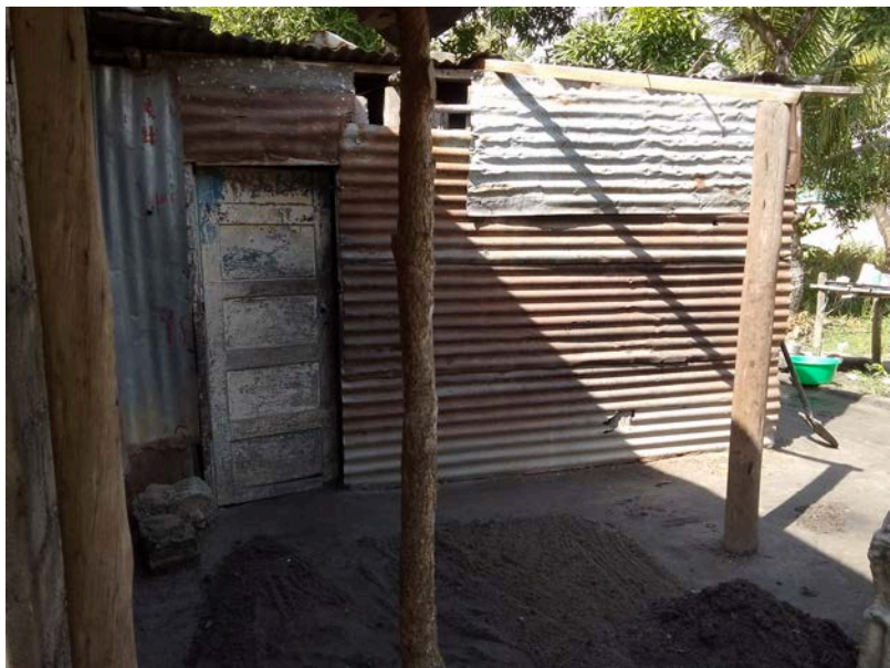
Habitação - Foto da esquina 2
