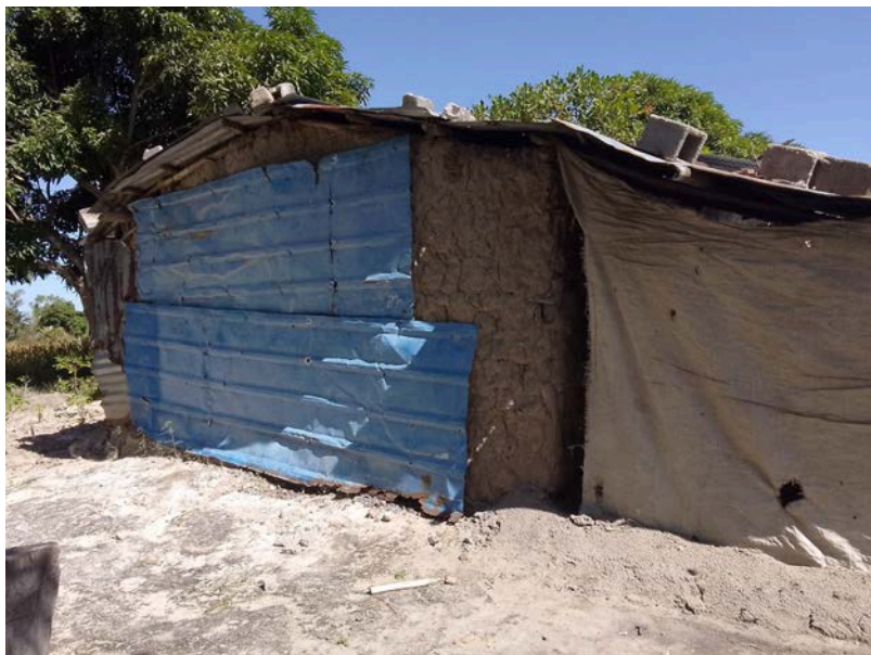
Habitação - Foto da esquina 2
