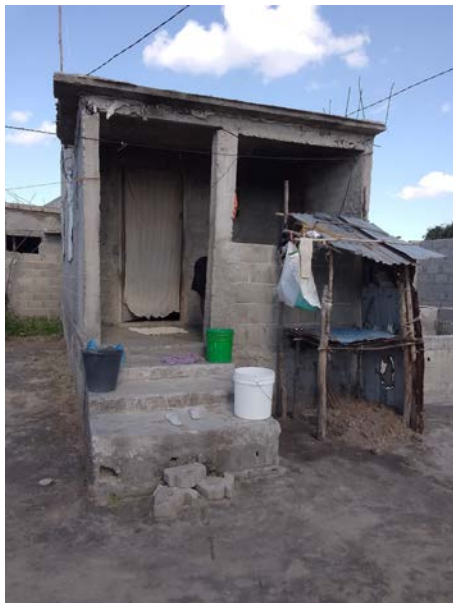
Habitação - Foto da esquina 2
