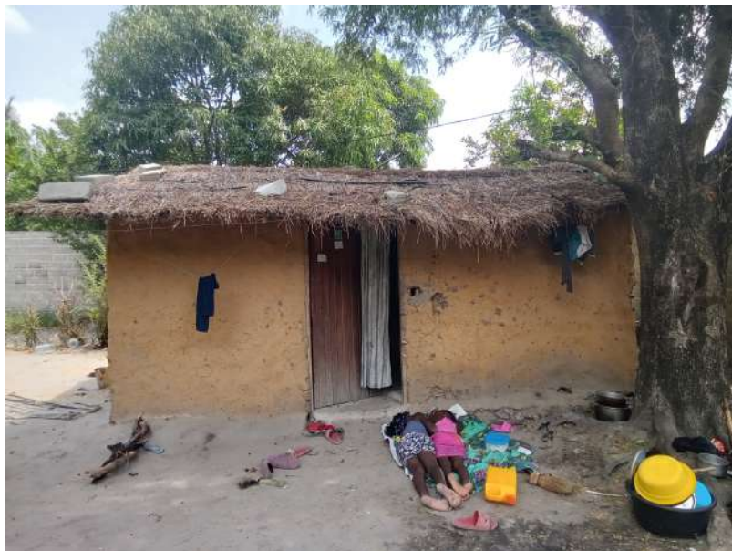
Habitação - Foto da esquina 2
