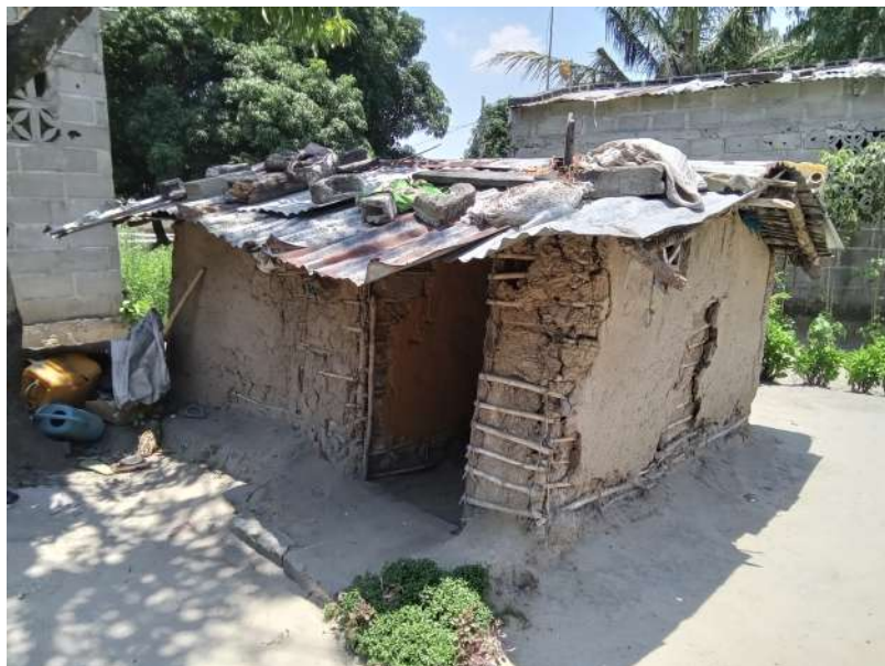
Habitação - Foto da esquina 2
