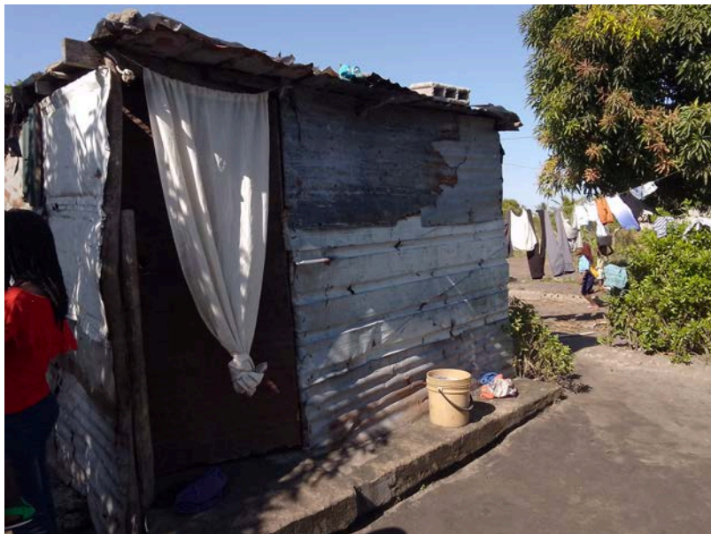
Habitação - Foto da esquina 2
