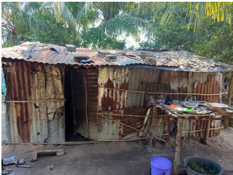
Habitação - Foto da esquina 2
