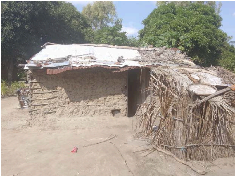
Habitação - Foto da esquina 2
