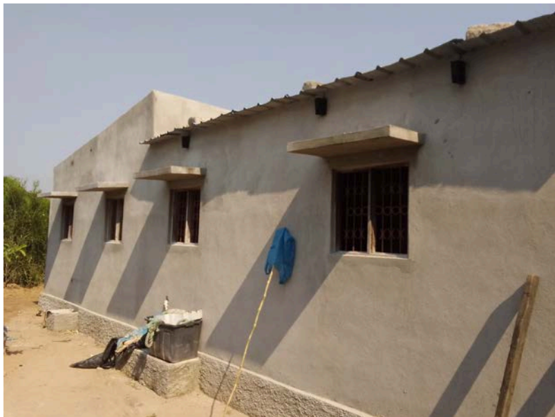
Habitação - Foto da esquina 2
