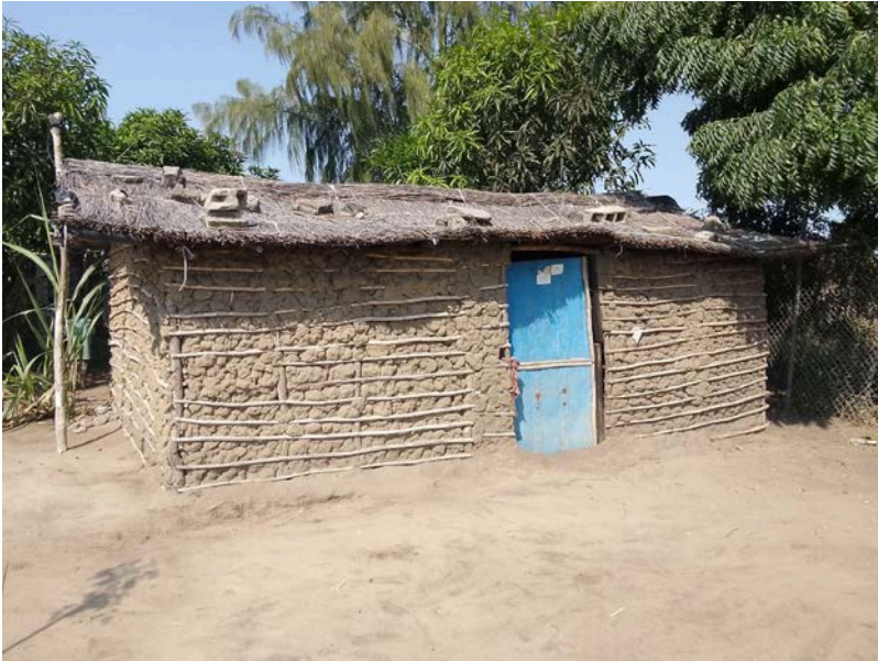
Habitação - Foto da esquina 2
