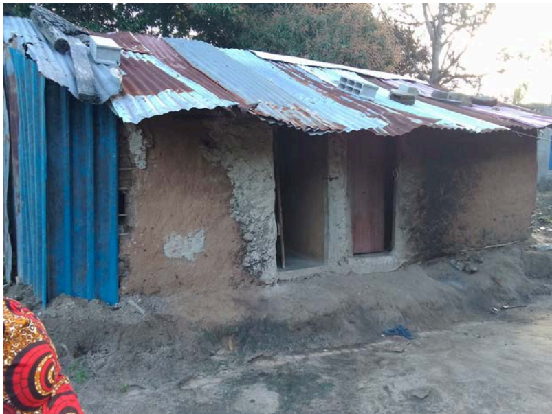
Habitação - Foto da esquina 2
