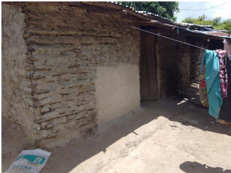
Habitação - Foto da esquina 2
