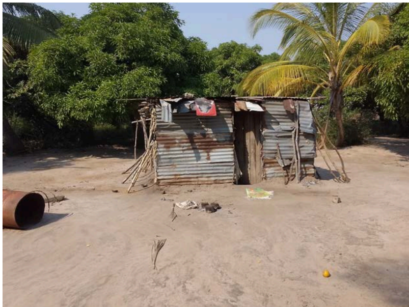
Habitação - Foto da esquina 2
