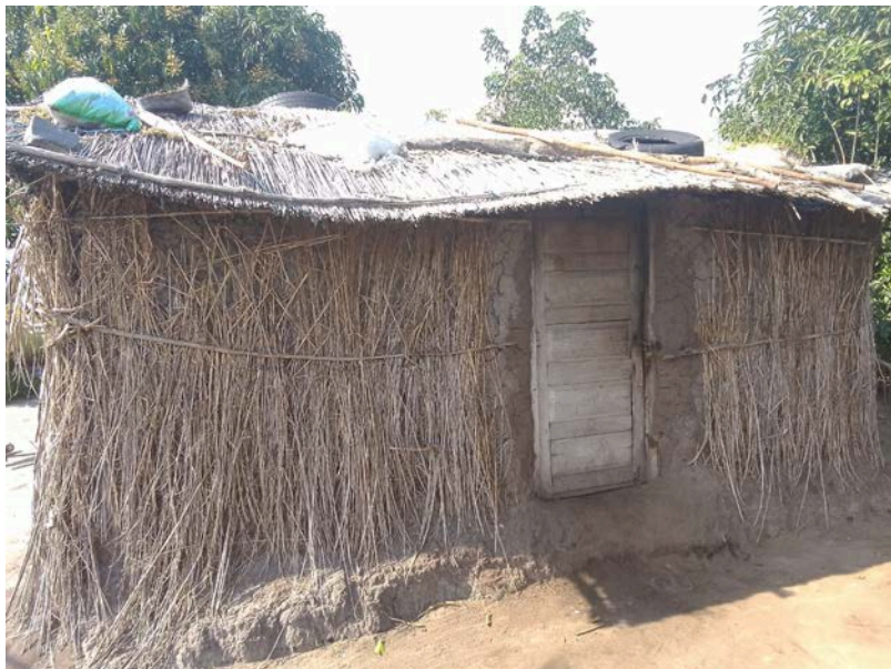
Habitação - Foto da esquina 2
