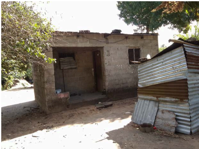
Habitação - Foto da esquina 2
