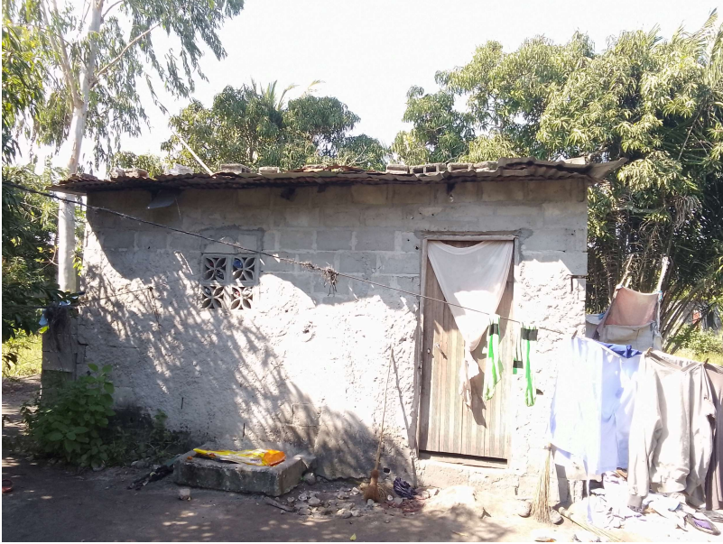
Habitação - Foto da esquina 2
