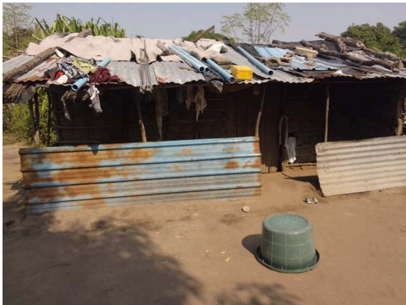
Habitação - Foto da esquina 2
