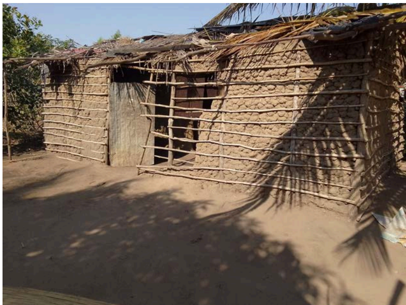
Habitação - Foto da esquina 2
