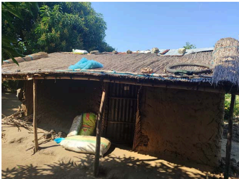
Habitação - Foto da esquina 2
