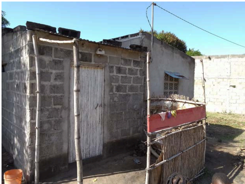
Habitação - Foto da esquina 2
