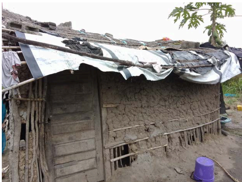
Habitação - Foto da esquina 2
