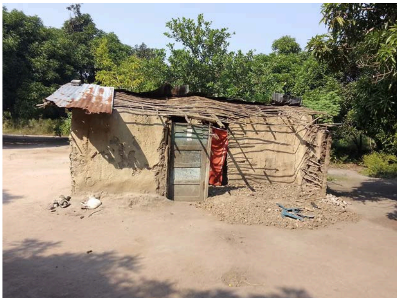
Habitação - Foto da esquina 2
