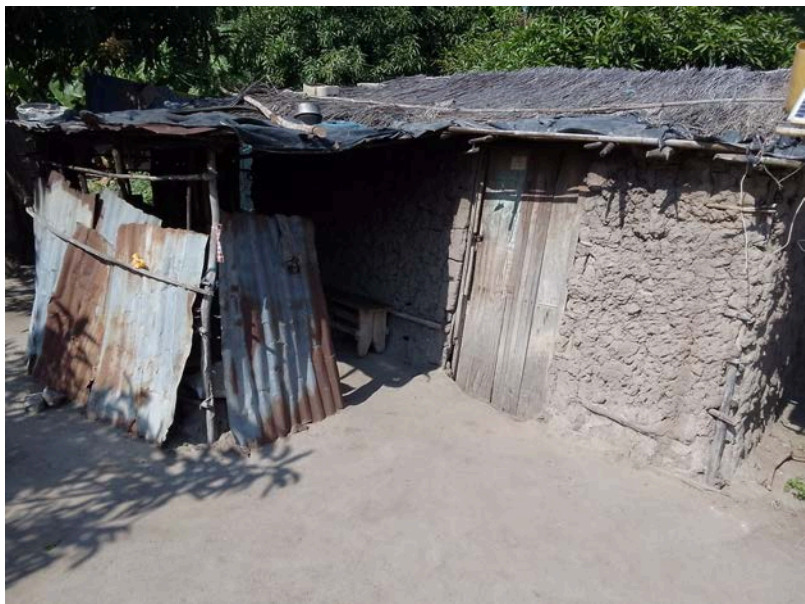
Habitação - Foto da esquina 2
