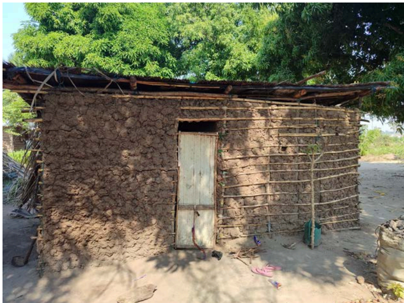
Habitação - Foto da esquina 2
