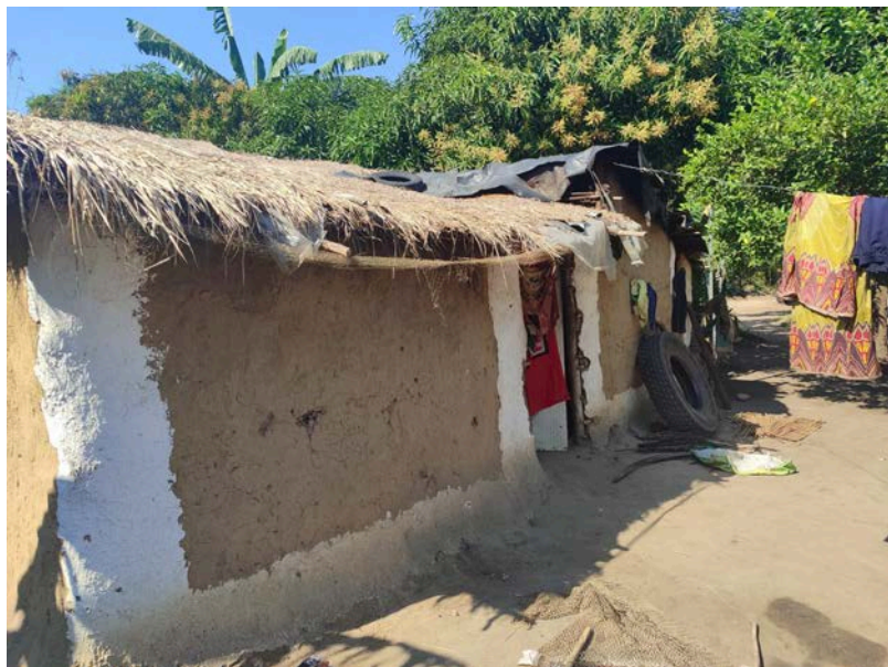
Habitação - Foto da esquina 2
