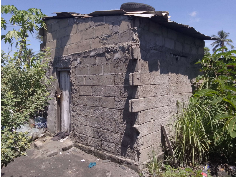
Habitação - Foto da esquina 2
