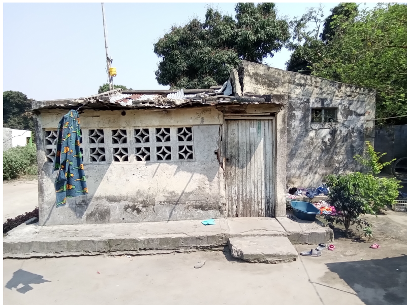
Habitação - Foto da esquina 2
