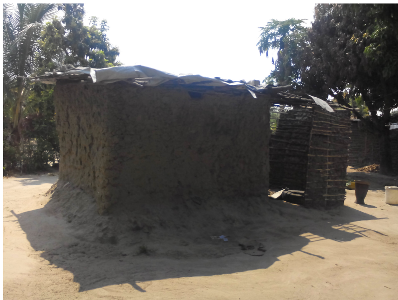
Habitação - Foto da esquina 2
