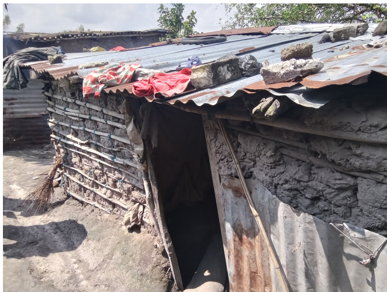
Habitação - Foto da esquina 2
