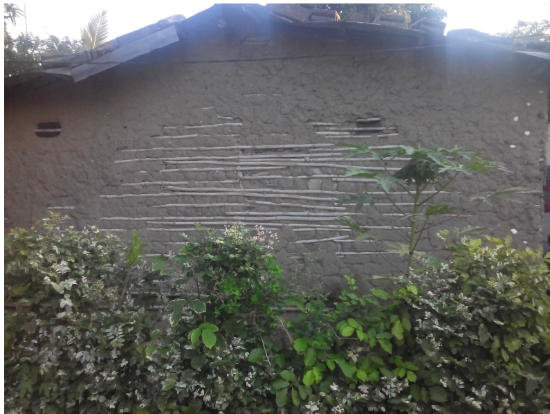
Habitação - Foto da esquina 2
