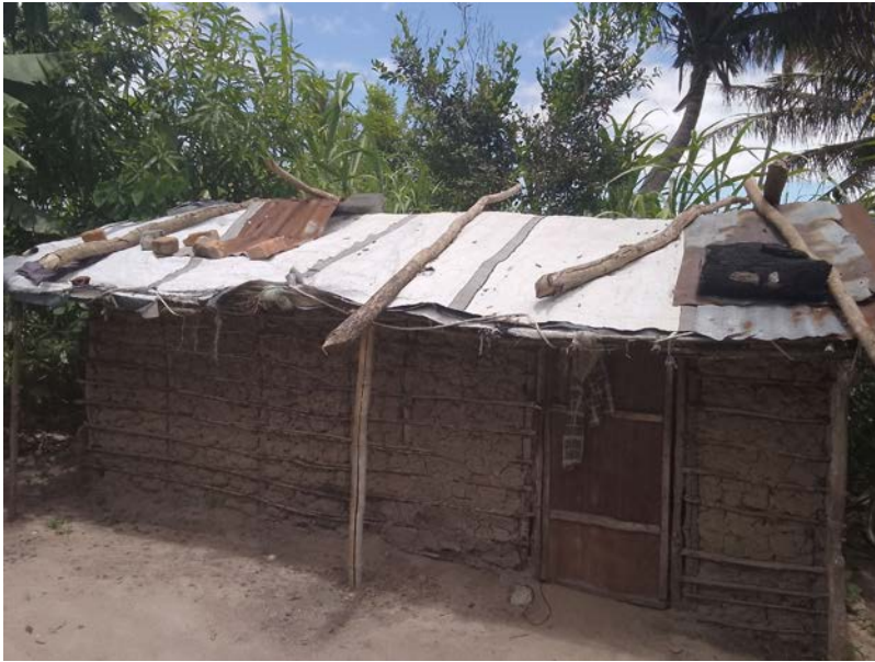
Habitação - Foto da esquina 2
